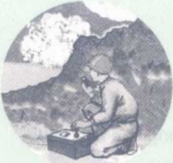
Phá đá bằng hỗn hợp nổ chứa oxy lỏng
